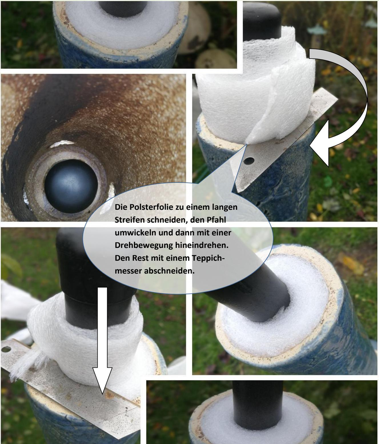
Die Polsterfolie zu einem langen Streifen schneiden, den Pfahl umwickeln und dann mit einer Drehbewegung hineindrehen. Den Rest mit einem Teppichmesser abschneiden.
